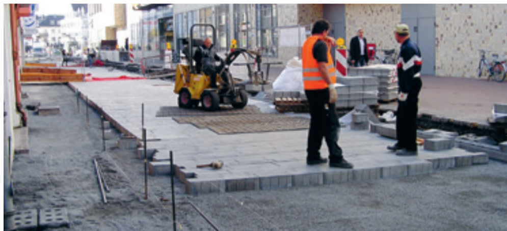
Fußgängerzone Stadtmitte in der Bauphase...
