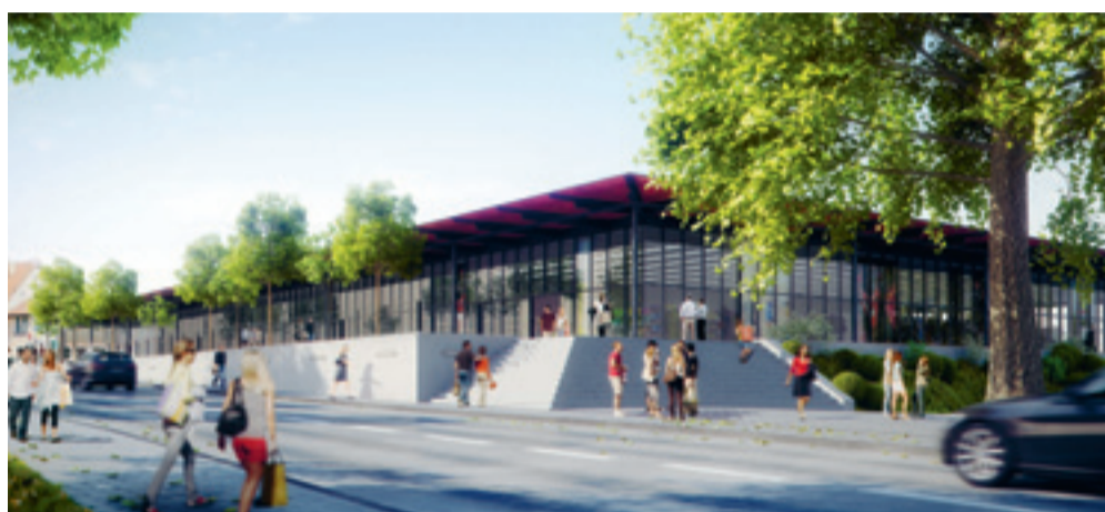
Lichtblick für den Campus Gronau – Gronauer Kreisel in der Planungsphase
